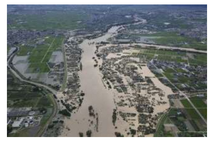
令和2年7月豪雨で氾濫した最上川
