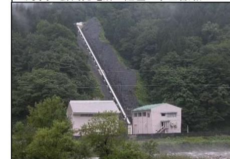
発電所建屋・水圧管路の完成イメージ (写真：蘇岡発電所の建屋・水圧管路)
