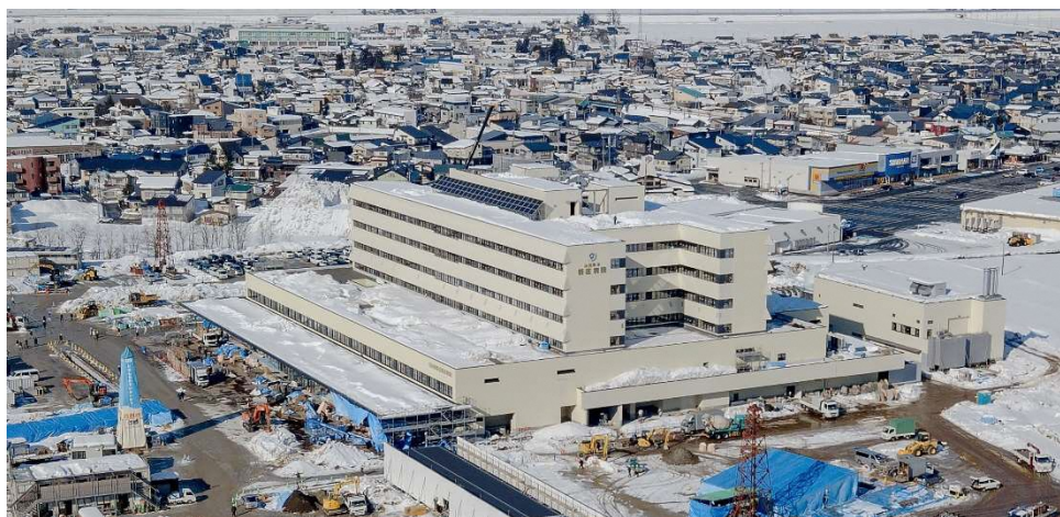
新庄病院 建設状況 (R5. 1. 19撮影)
