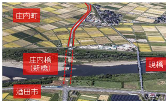
(一)余目松山線（庄内橋）
