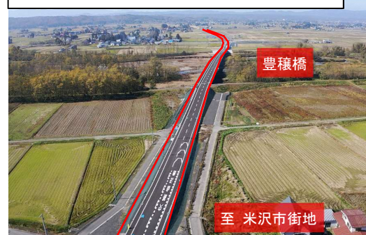
国道287号（米沢長井道路）
