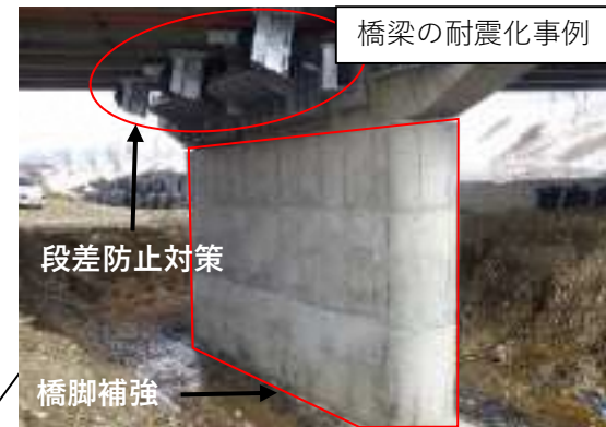
国道458号（升形橋）
