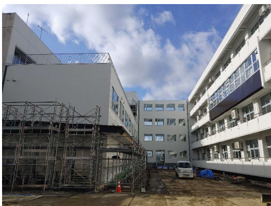
改修中の 致道館高校 ▶
