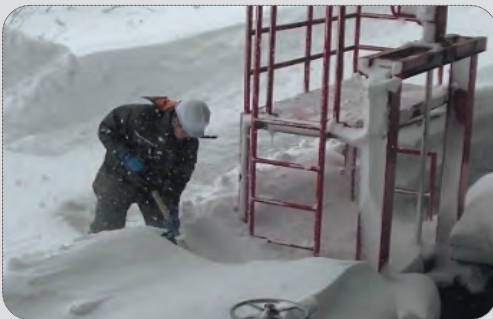
ゲート周辺の除雪の様子
