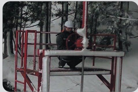
ゲート操作の様子
