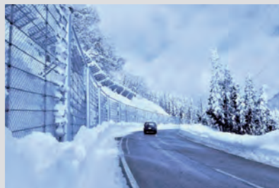
雪崩予防対策(吊柵+せり出し防止柵)
