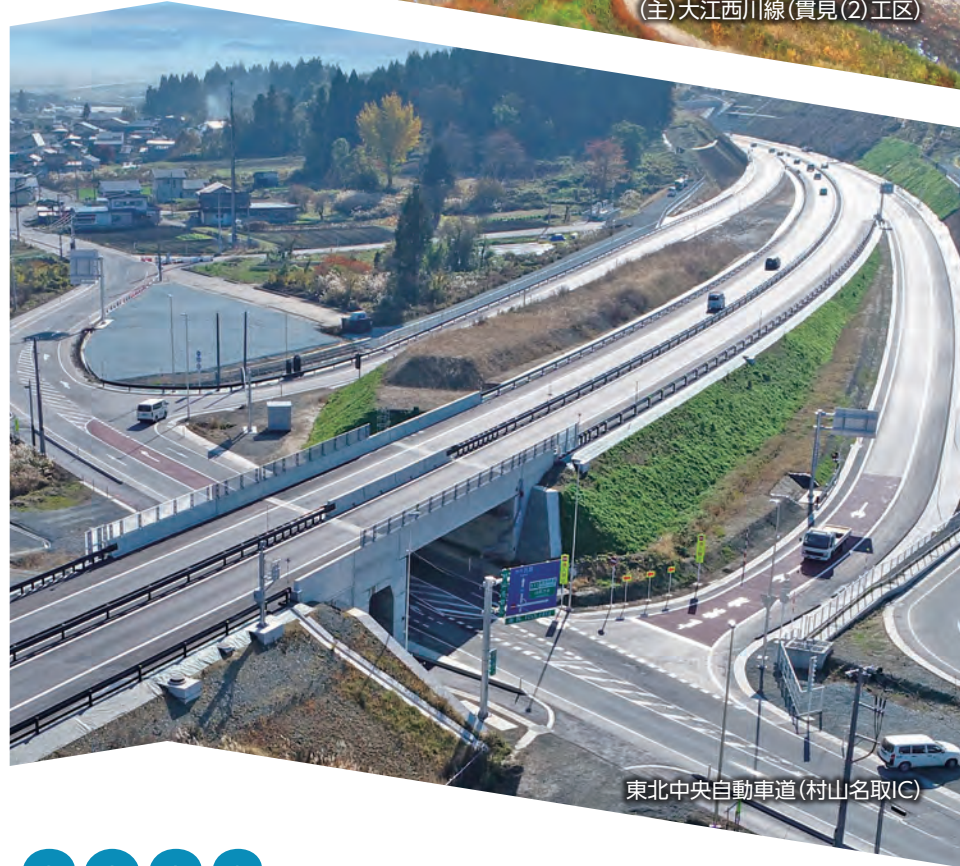
(主) 大江西川線 (貫見(2)工区)
