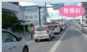
▲右折車線が無く、右折車が後続車の通行を阻害
