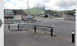
▲(主)上山七ヶ宿線 対策実施状況(交差点巻き込み部にガードパイプを設置)
