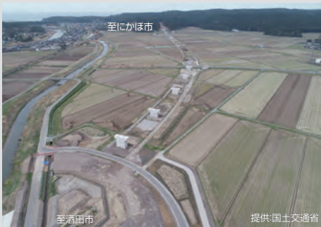
国道7号 遊佐象潟道路
