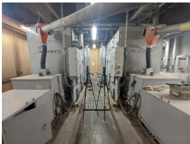
図表7 左：既存ペレットボイラ（暖房用・給湯用）2台 右：機械室
