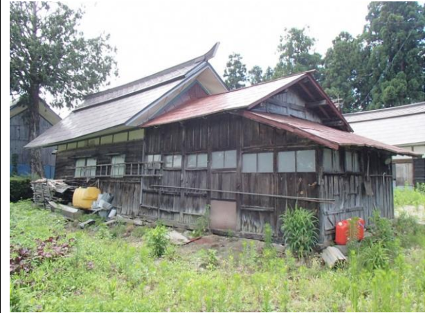
作業小屋及び牛舎
