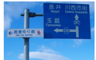
占有者負担で標識を添架した事例
