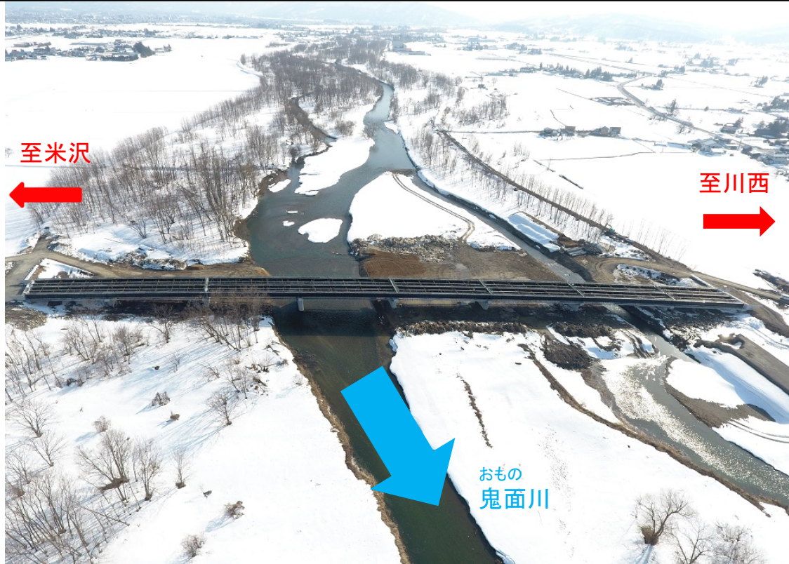
豊穰橋 橋長L=275m(桁架設完了 R4.3.12撮影)
