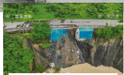
国道121号(米沢市入田沢)
