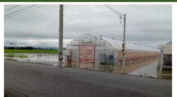
ハウス、露地の浸水 川西町堀金
