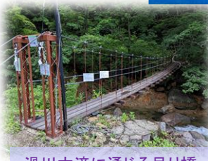
滑川大滝に通じる吊り橋 CFIにより7月に完成
