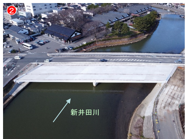
▲橋梁整備状況 (R3.4.5)
