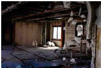
改修前（空きフロア）
