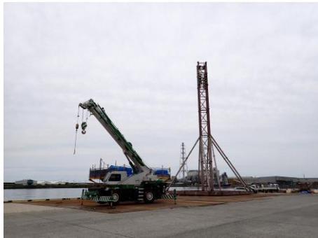
鋼製檣の組み立て
