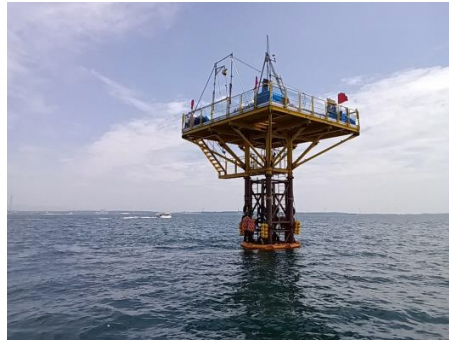
鋼製檣の設置状況
