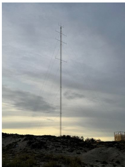
風況観測マスト (十里塚のみ設置)
