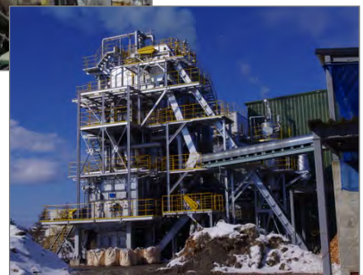
バイオマス発電施設
