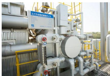
焼却廃熱の熱交換を行い、管内の水を蒸気として取り出します。
