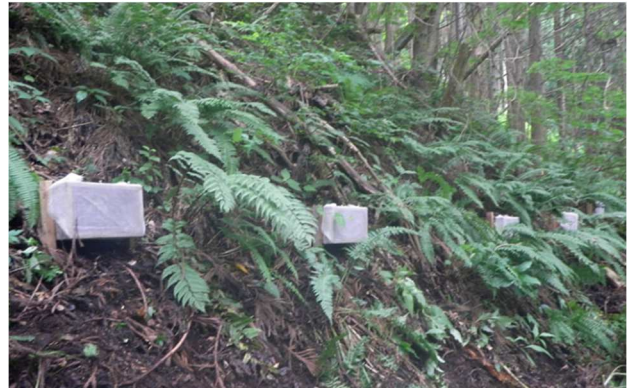
図 土砂受け箱設置状況写真
