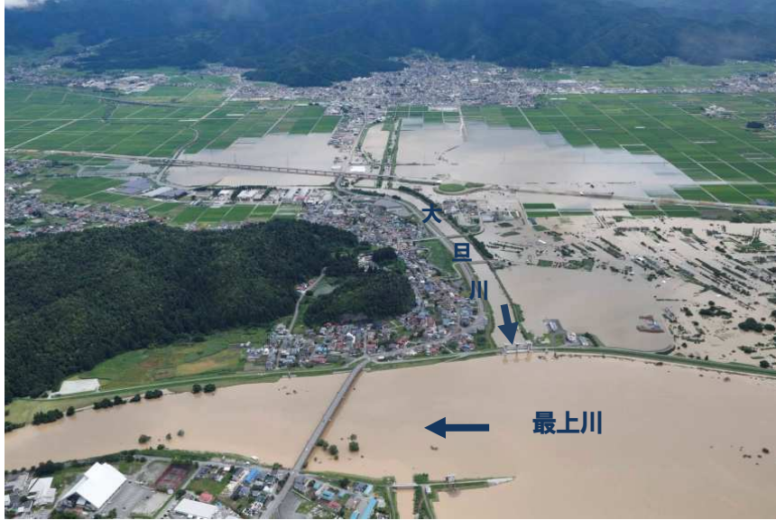
一級河川大目川（令和2年7月浸水被害状況）
