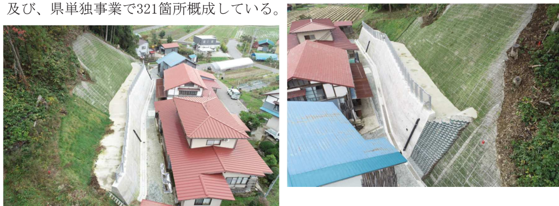
大淀 急傾斜地崩壊対策事業（村山市:完了後 撮影）
