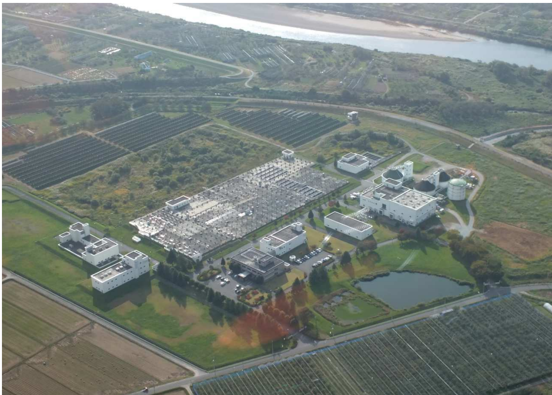
最上川流域下水道山形浄化センター全景
