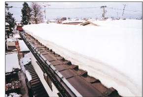
【克雪化の例】 屋根に融雪設備を設置
