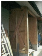
【減災・部分補強の例】 壁に構造用合板を設置、防災ベッドの設置
