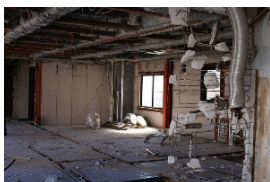
改修前 (空きフロア)
