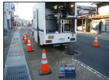
写真 管渠点検調査 (テレビカメラ調査)
