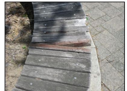
最上川ふるさと総合公園 休養設備修繕
