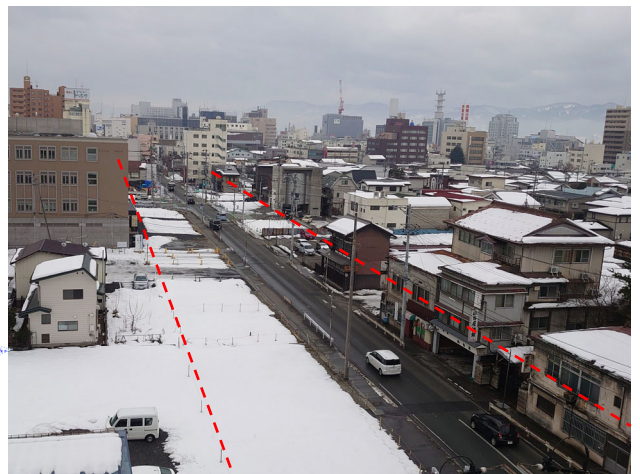
事業進捗状況（R3.1）北から南を望む
