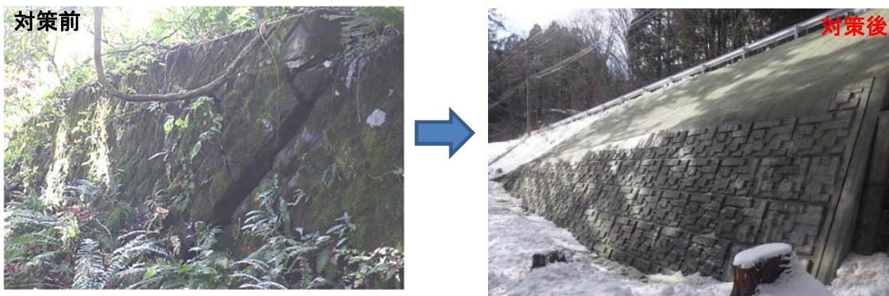
擁壁補修+上法面の植生を実施
