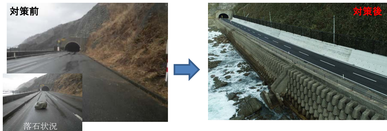
擁壁工+落石防護柵工を実施
