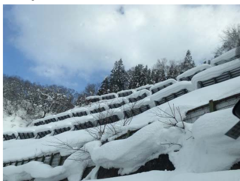
雪崩対策の例
