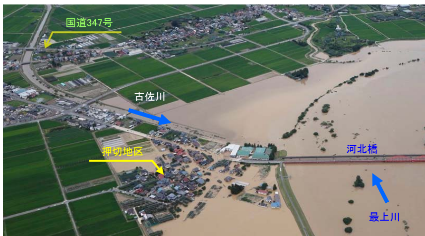
【古佐川】河北町押切地区浸水状況(R2.7.29)
