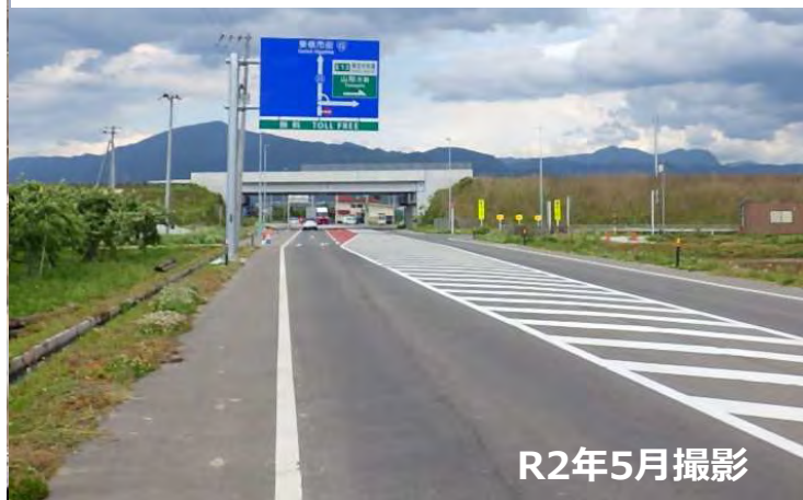
②現道状況 河北→長瀬方向
