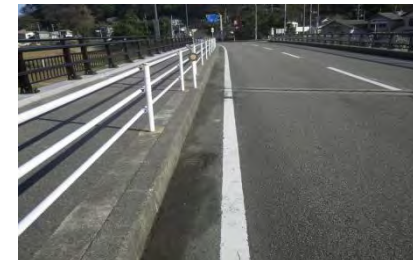
弁天橋の橋梁補修(完成)
