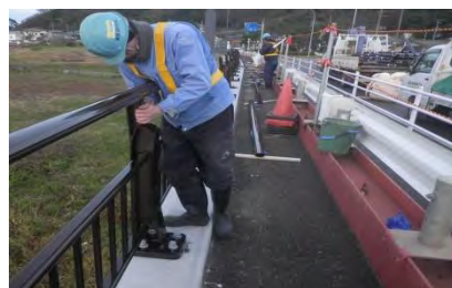
弁天橋の橋梁改修
