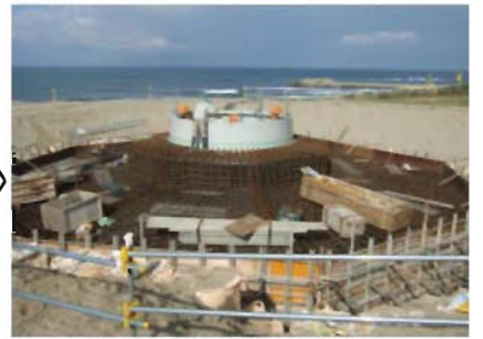
基礎工事（鉄筋組立）
