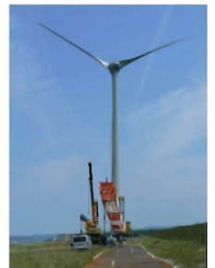
据付工事（組立完了）
