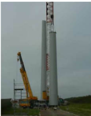
据付工事（タワー組立）
