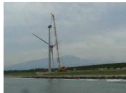
据付工事（ブレード取付）
