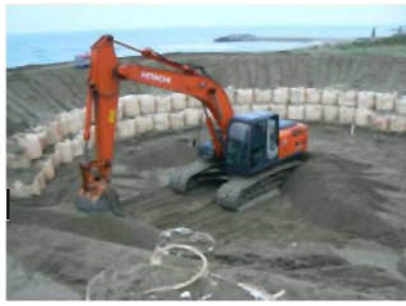
基礎工事（造成）
