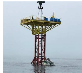
<ボーリング調査>
