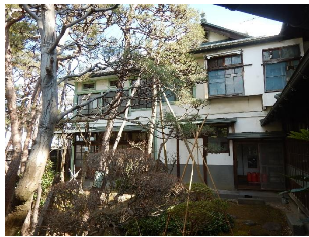
診療棟（フィニアル付き入母屋造り屋根）
