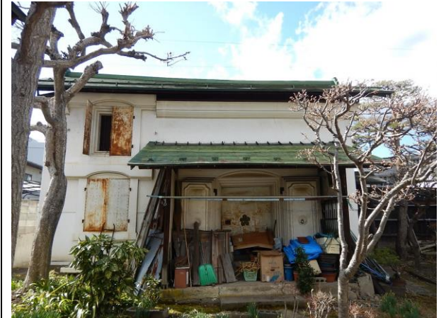
穀物蔵（開口部に鳥居枠を設置）
