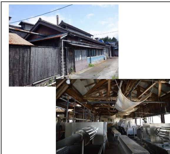
染色棟（旧染色室及び旧気罐室）
