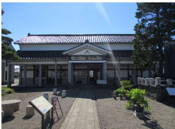
東田川電気事業組合倉庫
