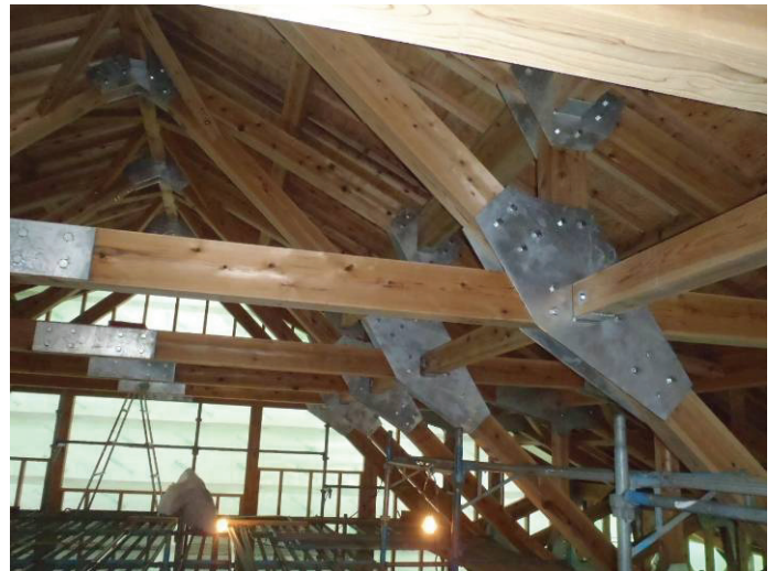
《プレイルーム小屋組状況》
