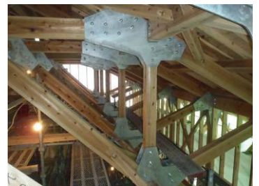
《柱と梁・桁・筋違の交差部》
