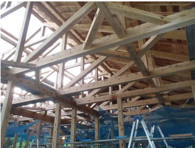
《高等部小屋組状況》
