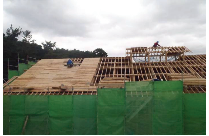
《屋根野地板張》 桧板使用（県産材）
