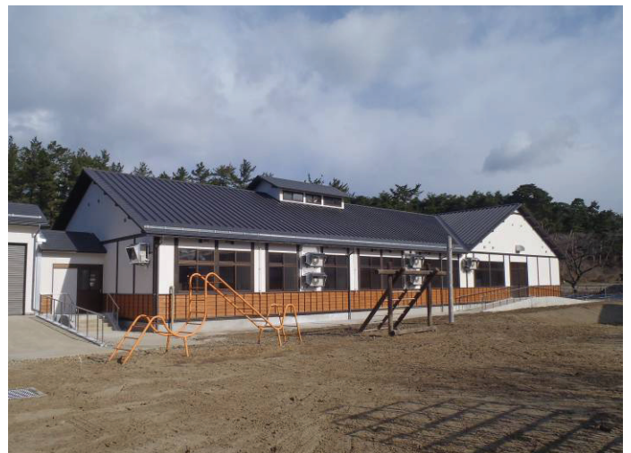
《小学部前運動場》外壁の腰壁にも木材を使用
