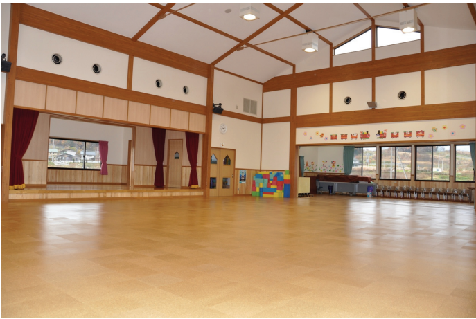
《遊戯室》スパン約11mの大空間には集成材を利用し、木質大断面構造とした
