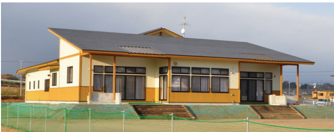
《外観写真》屋根からの落雪を考慮し落雪部へ緩衝帯を設けた
