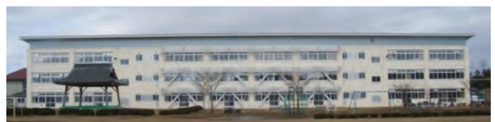
《外観写真》耐震補強として鉄骨ブレースを取り付けた
