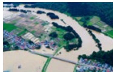
最上川の氾濫状況(大石田町豊田)
