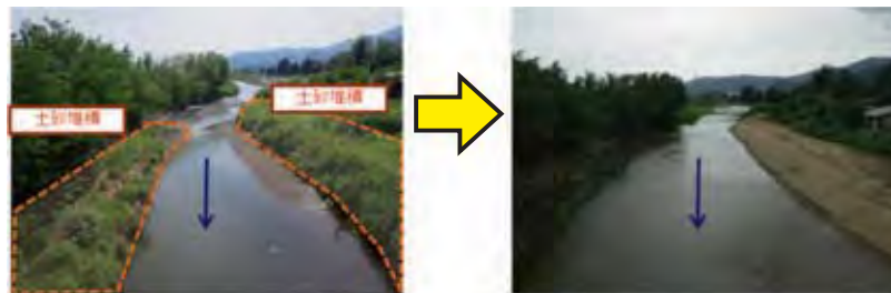
河川堆積土砂の掘削（着工前後比較） 上山市 須川 [県単独：河積回復減災対策事業]
